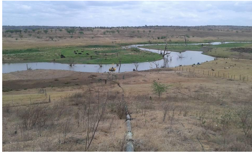
3. Barragem com nível de água menor que 5%. Agosto de 2015.
