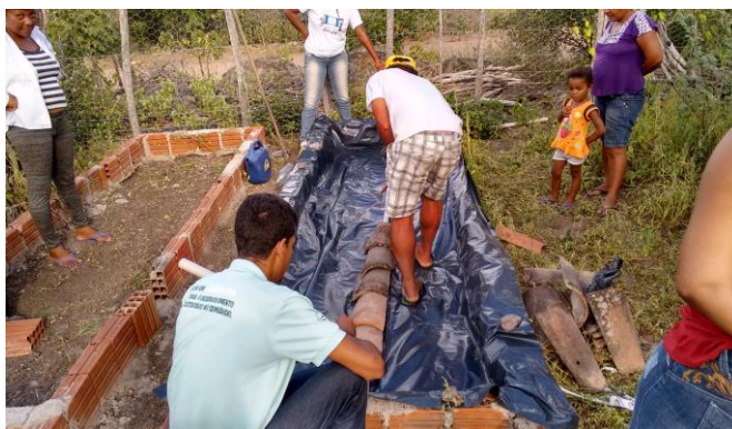
Figura 5 – Construção de Canteiro Econômico durante atividade coletiva. 2017. Fonte: arquivo da APPJ.
